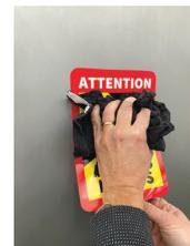
5 - Appliquer l'adhésif avec un chiffon doux et propre pour éviter la formation de bulles d'air
