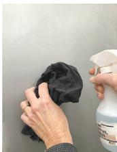
1 - Nettoyer, dégraisser, sécher l'endroit (lisse) où l'adhésif va être collé
